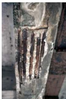
**Fig. 26 - Struttura da rinforzare che presenta un grave degrado per corrosione delle armature metalliche**
