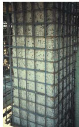
**Fig. 4 - Applicazione di nuovi ferri di armatura**
