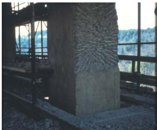
**Fig. 2 - Scarifica del calcestruzzo danneggiato per rimuovere gli agenti aggressivi penetrati e predisporre un substrato irruvidito per migliorare l'aderenza alla malta da restauro**
