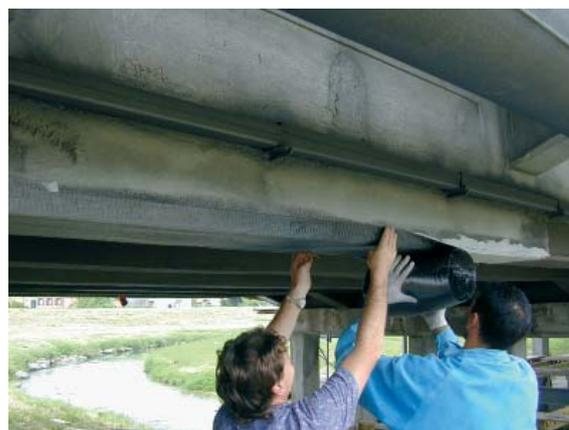
**Fig. 32 - Stesura a secco del tessuto da impregnare**
