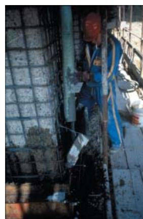
**Fig. 10 - Applicazione per colaggio della malta entro i casseri predisposti sulla struttura da riparare precedentemente saturata con acqua**
