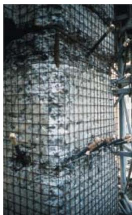
**Fig. 12 - Predisposizione di tubicini attraverso i quali si può iniettare il liquido polimerico per riempire le cavità o le lesioni interne**
