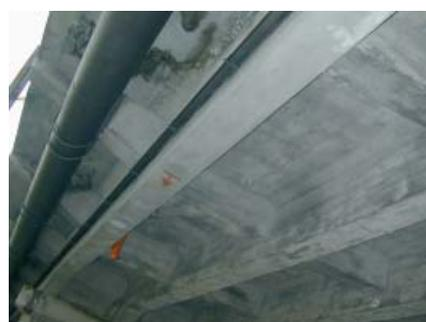
**Fig. 29 - Sezione della struttura in calcestruzzo ripristinata con malta tixotropica**
