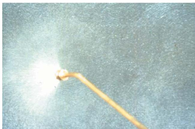
**Fig. 9 - Applicazione di un agente stagionante nebulizzato sulla superficie della malta da restauro**
