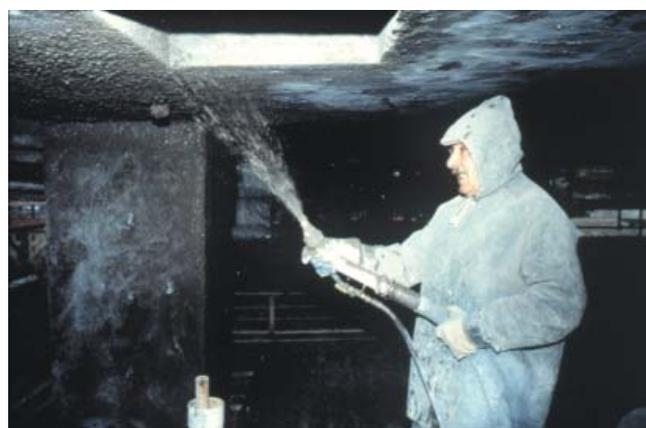
**Fig. 7 - Applicazione a spruzzo della malta da restauro proiettata all'intradosso di un solaio in calcestruzzo**
