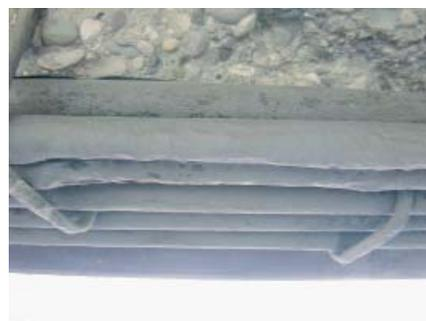
**Fig. 28 - Armature metalliche dopo le operazioni di sabbiatura**
