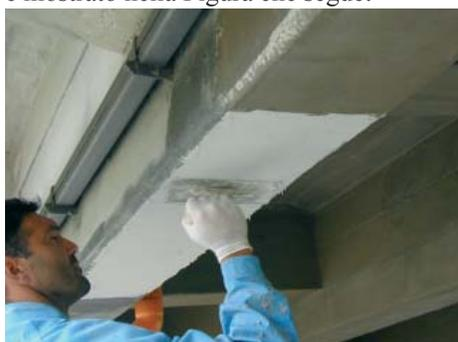
**Fig. 31 - Applicazione a spatola della resina epossidica in pasta**
