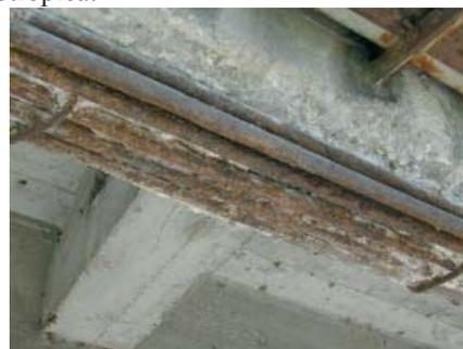
**Fig. 27 - Scarifica del calcestruzzo degradato con completa messa a nudo dei ferri in fase di corrosione**
