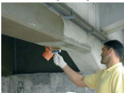
**Fig. 30 - Applicazione del primer epossidico fluido**
