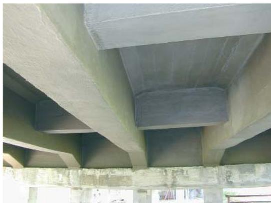
**Fig. 34 - Protezione finale dei rinforzi in FRP dai raggi ultravioletti con un rivestimento flessibile in polimerocemento**
