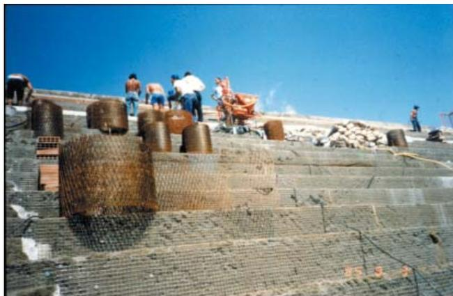
**Fig. 5 - Applicazione della rete elettrosaldata sulla superficie di calcestruzzo scarificato**
