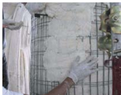
Fig. 9 - Applicazione del sistema anodico sulla colonna C.
