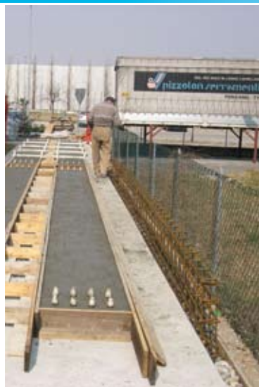
Fig. 2 - Proves di campo sulle lastre di calcestruzzo bloccate alle estremità ed esposte al ritiro igrometrico vincolato.
