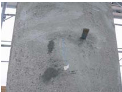
Fig. 8 - Riparazione del calcestruzzo danneggiato e collegamenti elettrici sulla colonna C.
