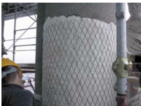
Fig. 10 - Applicazione del sistema anodico sulla colonna E.
