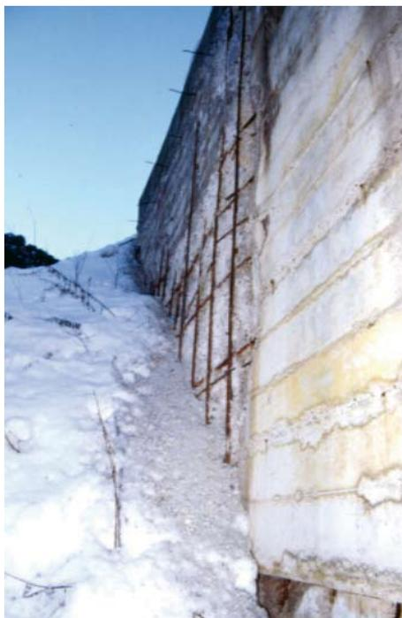
Fig. 1 - Degrado di un muro in c.a. per effetto del ghiaccio.
