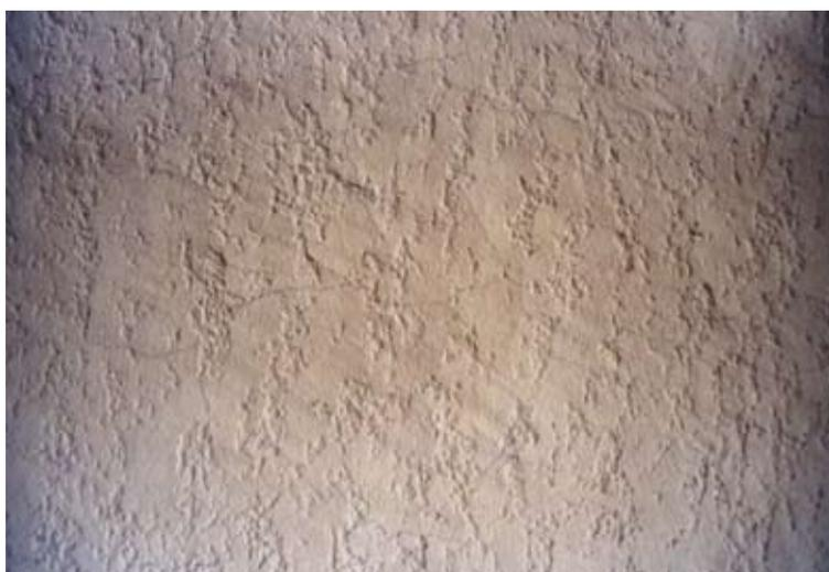
Fig. 1 - L'intonaco contenente amianto fotografato da circa un metro di distanza.
