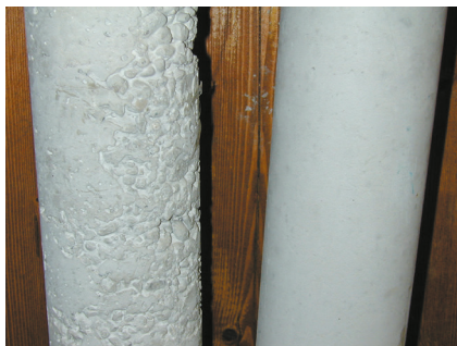
Fig. 2 - Facciavista marmorizzato. Confronto tra calcestruzzo S5 (a sinistra) ed SCC (a destra) entrambi gettati senza vibrazione
