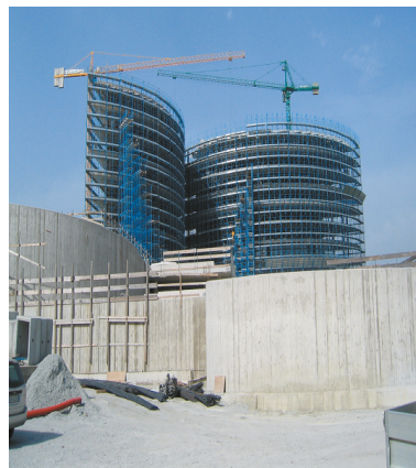
Fig. 4 - Vista d'insieme del World Trade Center di San Marino nella fase costruttiva
