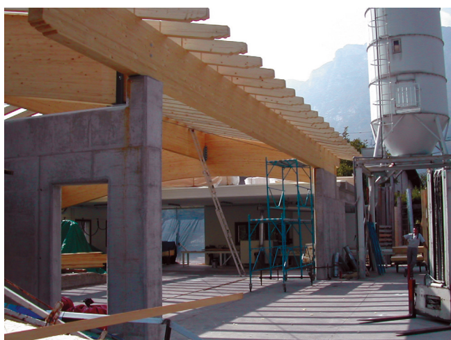
Fig. 5 - Trave principale in legno armato di copertura
