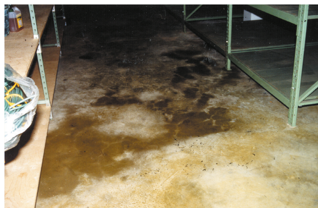
Fig. 5 - Vistose macchie nere determinate dalla presenza nel terreno di sottofondo di rifiuti organici trasportati sulla superficie dall'acqua risalente
