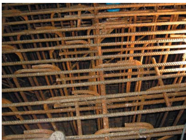
Fig. 4 - Particolare della fondazione armata
