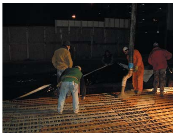
Fig. 5 - Aspetto eccessivamente coloso dell' SCC iniziale che rallentava la portata del getto
