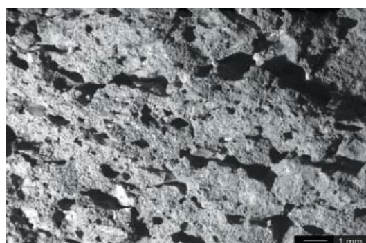
Fig. 2 - Bolle prodotte dall'idrogeno intrappolato nella matrice cementizia del calcestruzzo confezionato con le ceneri pesanti da RSU macinate a secco
