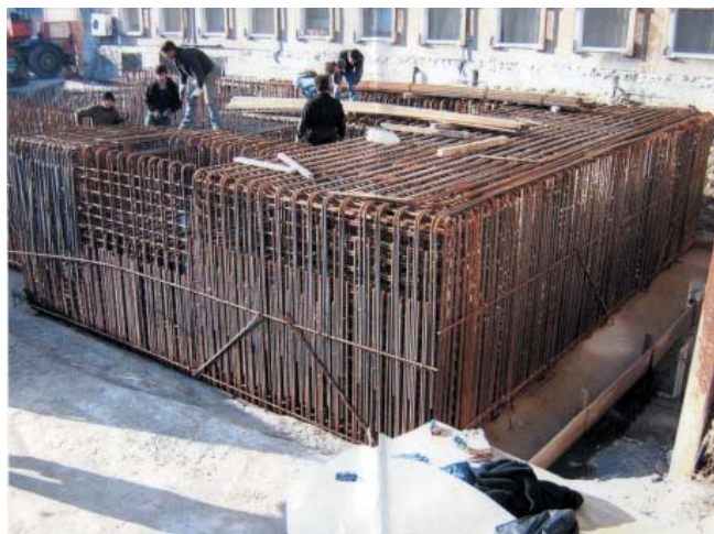
Fig. 3 - Vista d'insieme della fondazione armata prima del getto
