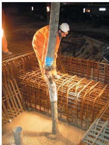
Fig. 6 - Getto di SCC molto fluido
