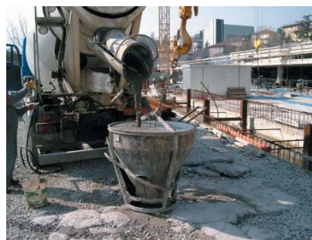
Fig. 6 - L'SCC impiegato a San Marino per il Trade World Center
