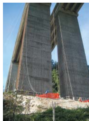
Fig. 9 - Vista d'insieme delle pile dei ponti scarificate prima di applicare l'SCC a ritiro compensato come in Fig. 7
