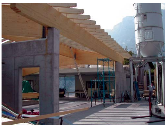
Fig. 5 - Trave principale in legno armato di copertura
