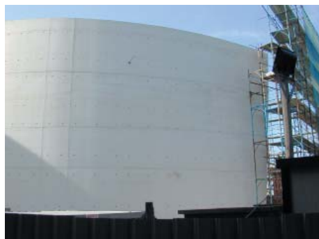
Fig. 1 - Le vele bianche in SCC in fase di esecuzione per la Chiesa di S. Pietro Apostolo di Pescara
