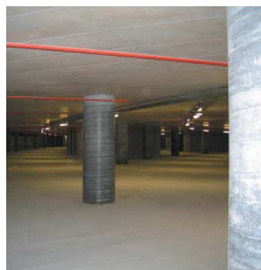
Fig. 5 - Pochi pilastri ( R = 90\text{MPa} ) per grandi spazi nel parcheggio a piano terra del World Trade Center di San Marino
