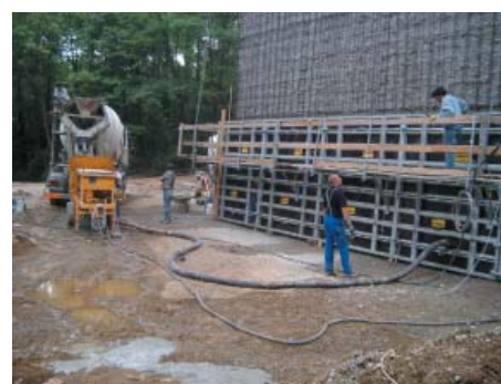
Fig. 10 - Fase di getto dell'SCC a ritiro compensato pompato e gettato entro casseri
