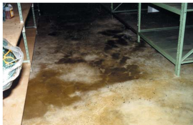
Fig. 5 - Vistose macche nere determinate dalla presenza nel terreno di sottofondo di rifiuti organici trasportati sulla superficie dall'acqua risalente
