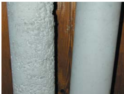
Fig. 2 - Facciavista marmorizzato. Confronto tra calcestruzzo S5 (a sinistra) ed SCC (a destra) entrambi gettati senza vibrazione
