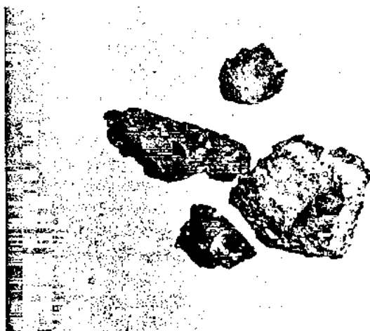
Fig. 12 - Pop-out del pavimento della Figura 11 con i granuli dell'aggregato reattivo parzialmente attaccati allo spolvero della pavimentazione.
