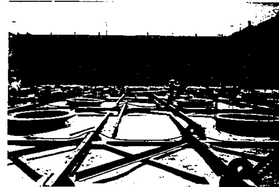
Fig. 19 - Particolare della platea di fondazione gettata in subacqueo: si notino le estremità superiori dei tralicci emergenti dal getto.
