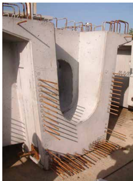
Figura 1 – La faccia anteriore di un prototipo con precompressione, longitudinale e trasversale inferiore
