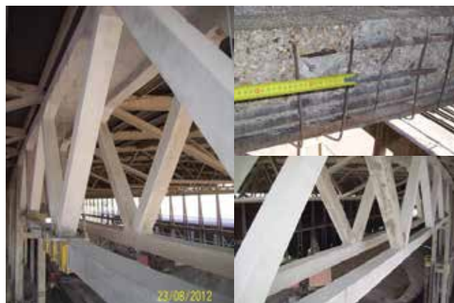
Fig. 11 – Il ringrosso con malta Emaco SFR dei tiranti degradati della capriata
