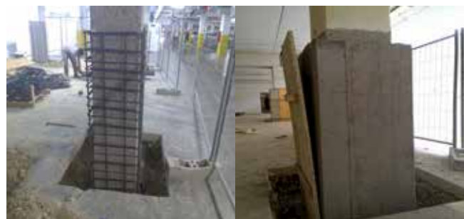
Fig. 9 - Il ringrosso di pilastri prefabbricati per l'adeguamento sismico dallo spiccato della fondazione con cls con EMACO A660 FR
