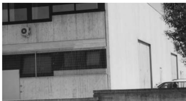
**Fig. 6 – Sulla superficie dell'edificio a sinistra si nota la tipica deturpazione scura provocata dall'umidità, mentre a destra - sulla superficie esposta al sole - la deturpazione è assente**
