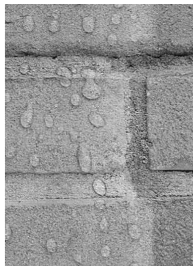
Fig. 8 – La parte destra della muratura - non trattata con silano - assorbe l'acqua piovana, mentre la parte sinistra trattata in superficie (a rullo) con il silano diventa idrorepellente e le gocce d'acqua scivolano dalla superficie del mattone e della malta senza penetrare il materiale
