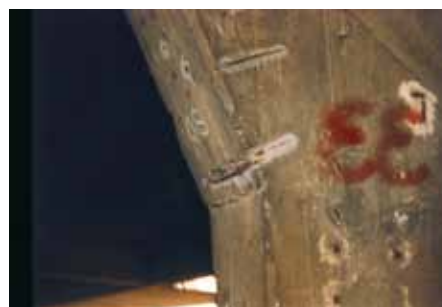
Fig. 2 - Vista dal basso delle pensiline con corrosione delle armature e rimozione dei copriferri
