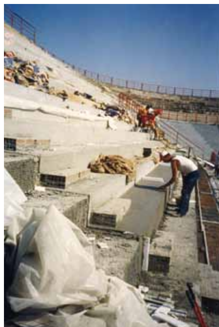
Fig. 6 - Applicazione a cazzuola della malta a ritiro compensato sulla pedata delle gradinate
