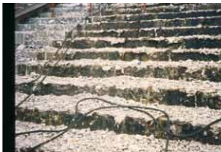
Fig. 3 - Rimozione del calcestruzzo ammalorato
