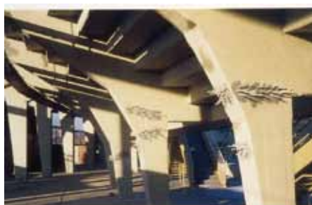
Fig. 8 - Consolidamento mediante iniezione di resina epossidica attraverso tubicini per il riempimento di vespai interni
