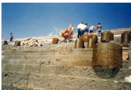
Fig. 4 - Applicazione della rete elettrosaldata
