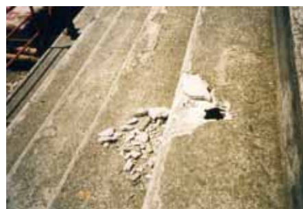
Fig. 1 - Vista delle gradinate il cui calcestruzzo risulta degradato in superficie
