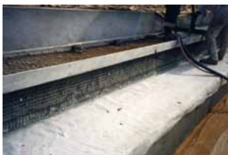
Fig. 5 - Applicazione a spruzzo della malta a ritiro compensato sull'alzata delle gradinate
