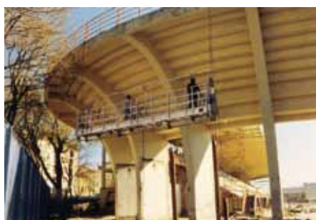
Fig. 7 - Trattamento in superficie per impermeabilizzare l'intradosso delle pensiline
