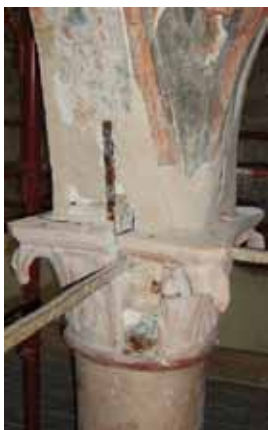
Fig. 2 - Fessure e distacchi di malta indotti dalla corrosione degli inserti in uno dei capitelli del ciborio.
