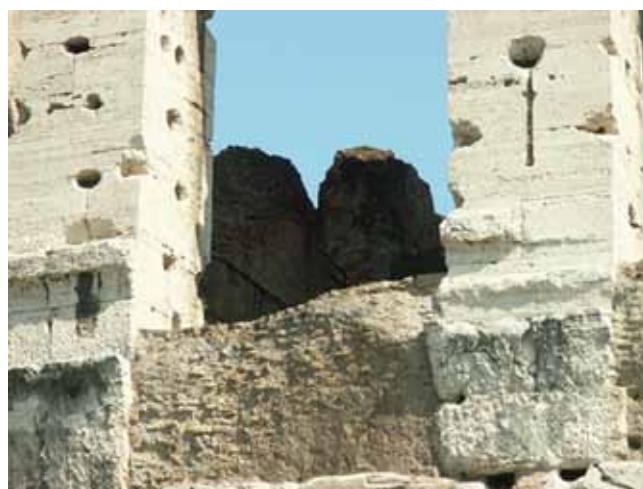
Fig. 6 - Blocchi di Travertino bianco dilavato in seguito alla solfatazione delle superfici.
