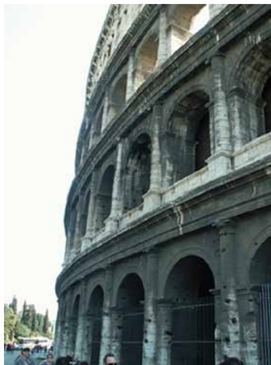
Fig. 5 - Zona del Colosseo più esposto al traffico automobilistico con emissioni di anidride solforosa e polveri sottili che provocano la formazione di croste nere.
