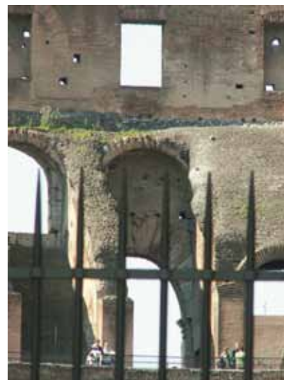
Fig. 4 - Calcestruzzo antico gettato tra paramenti in mattoni a perdere.
