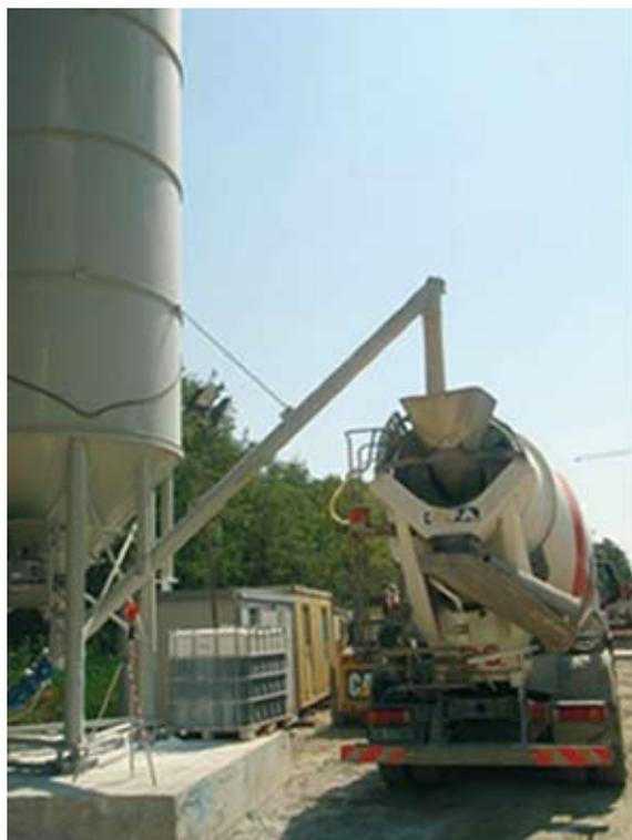
**Fig. 4 - Alimentazione automatica dell'agente espansivo dal silo sul cantiere.**
