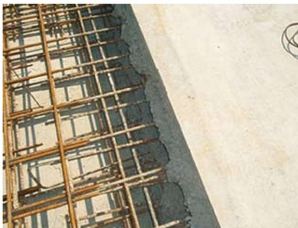
Fig. 1 - Armature metalliche ad aderenza migliorata che attraversano un giunto di costruzione.
