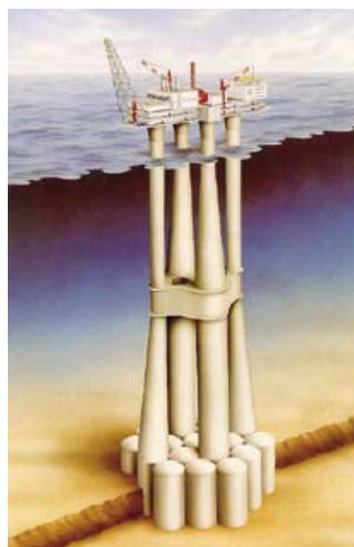
**Fig. 4 – Troll Gravity Base Structure (piattaforma marina per estrazione gas naturale) nel Mare del Nord. I piloni sono stati realizzati con la tecnica Slip forming, usando ligninsulfonato come fluidificante e nitrato di calcio per ottimizzare la velocità di formazione, senza dover modificare la temperatura di lavoro.**
