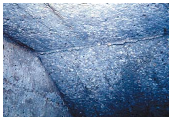
Fig. 8 - Dilavamento superficiale del calcestruzzo esposto all'azione di acque di fogna.
