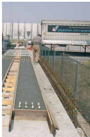
Fig. 5 - Vista delle lastre esposte all'aria aperta.
