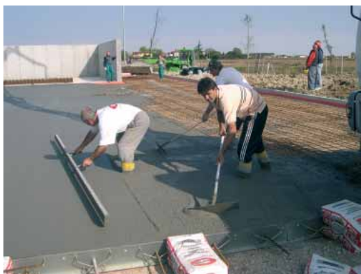
Fig. 7 - Stesura del calcestruzzo in presenza di rete metallica.
