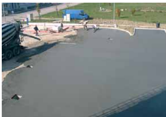
Fig. 8 - Stesura del calcestruzzo gettato in assenza di rete metallica.
