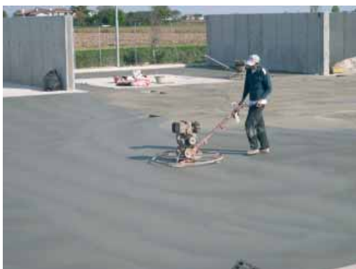
Fig. 6 - Finitura della superficie del pavimento con "elicottero".
