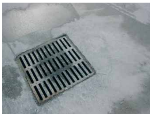
Fig. 10 - Esempio di cavillatura per difettosa finitura dei giunti di isolamento.
