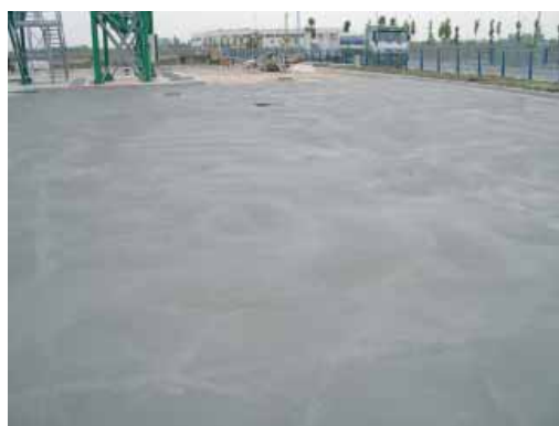
Fig. 8 - Vista della pavimentazione priva di giunti di contrazione.
