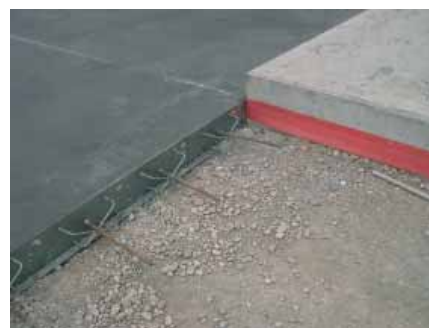
Fig. 9 - Giunto di contrazione (sulla sinistra) e di isolamento da una cordonatura adiacente alla pavimentazione.
