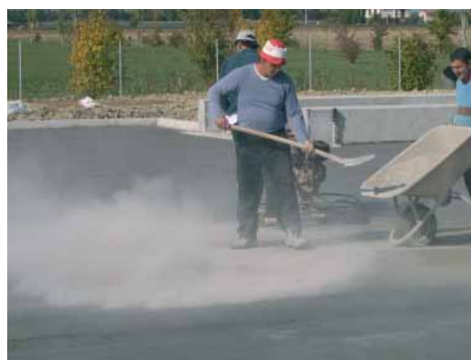
Fig. 9 - Applicazione dello spolvero cementizio per rinforzare la superficie della pavimentazione .
