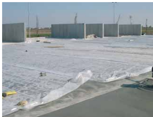
Fig. 7 - Protezione del pavimento con teli di plastica applicati dopo la finitura della superficie.
