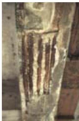
Fig. 3 – Particolare della corrosione delle barre metalliche in una trave in c.a. di una struttura esposta a salatura in inverno
