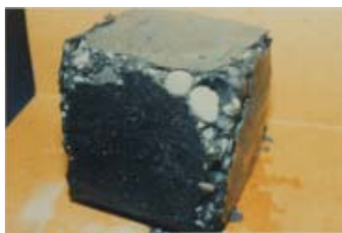
Fig. 8 – Distacco tra aggregato e matrice cementizia degradata dal CaCl_2
