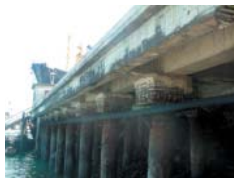
Fig. 2 – Corrosione dei ferri promossa dalla presenza del cloruro in acqua di mare sulle zone di bagna-asciuga o esposte agli spruzzi dell'acqua
