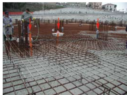
Fig. 7 - Platea di fondazione del parcheggio degli Archi e localizzazione dei relativi punti di monitoraggio.
