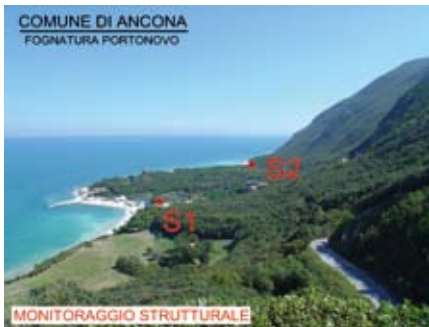
Fig. 1 - Opera monitorata: stazioni di pompaggio S1 e S2 (Portonovo, Ancona).
