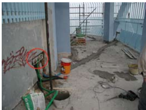
Fig. 14 - Cassetta di smistamento dati.
