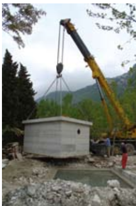
Fig. 2 - Messa in opera della stazione S1.
