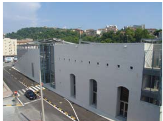
Fig. 6 - Opera monitorata: parcheggio degli Archi (Ancona).
