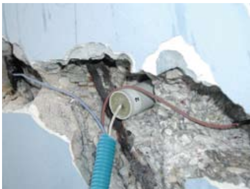
Fig. 13 - Inserimento di un elettrodo di riferimento in una struttura esistente.
