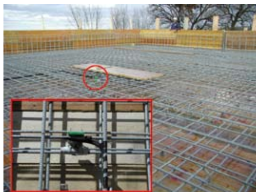
Fig. 18 - Punto di monitoraggio della soletta superiore del serbatoio Brancadoro.
