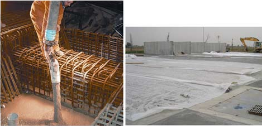
Fig. 5 - Getto di un conglomerato SCC messo in opera senza vibrazione e stagionatura di un pavimento con teli impermeabili.
