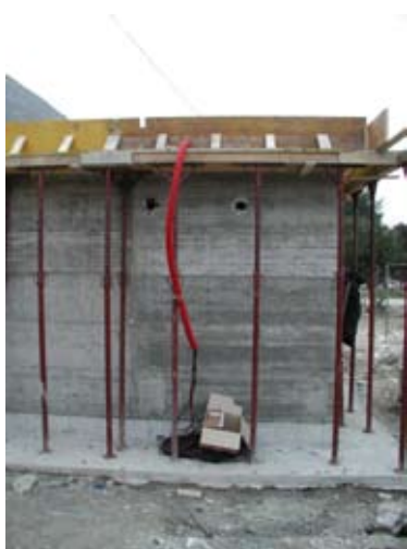
Fig. 4 - Cavi di collegamento alla centralina di telelettura.
