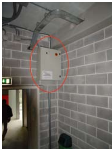
Fig. 10 - Centralina di trasmissione dati.
