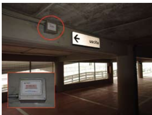
Fig. 9 - Scatola d'ispezione di un punto di monitoraggio.
