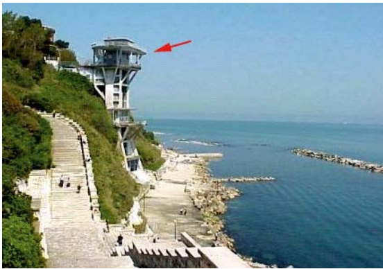
Fig. 12 - Opera monitorata: ascensore del Passetto (Ancona).
