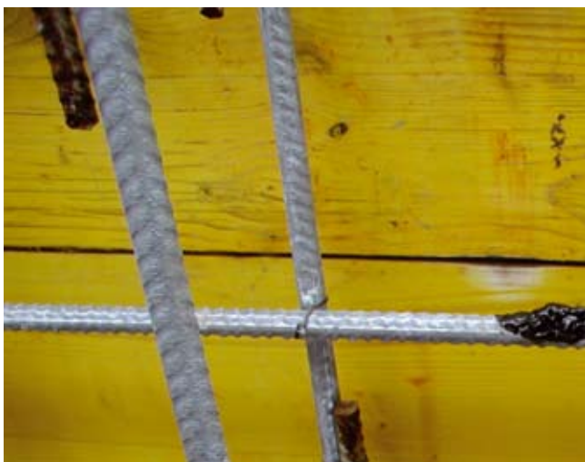
Fig. 6 - Elettrodi di lettura collegati alle armature metalliche della struttura in c.a.
