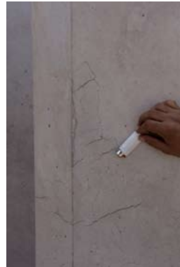
Fig. 2 - Copriferro fessurato da tensioni di trazione dovute al ritiro differenziale.
