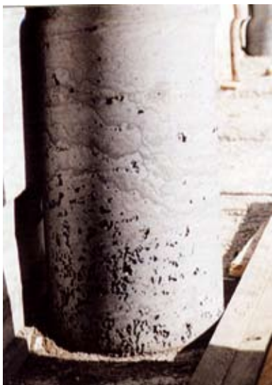
Fig. 1 - Presenza di macrovuoti d'aria intrappolata nel calcestruzzo per incompleta compattazione.
