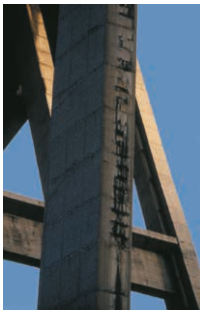
Fig. 4 - Corrosione dei ferri di armatura per la carbonatazione prematura del copri ferro in corrispondenza delle fessure indotte dal ritiro
