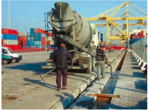
Fig. 12 - Completamento di un getto in SCC nel porto di Livorno (Gabriele Ciatti, Betonval).
