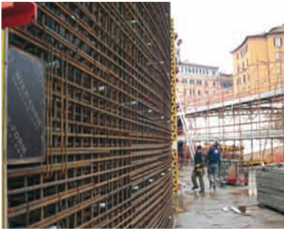
Fig. 9 - Le armature metalliche di un muro del MAXXI, Roma (Marco Odoardi, Italiana Costruzioni).
