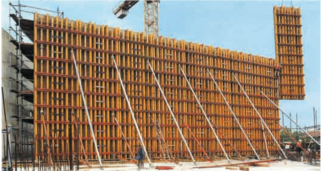
Fig. 17 – Esempio di casseforme rinforzate con sostegni a perfetta tenuta per getto di SCC.
