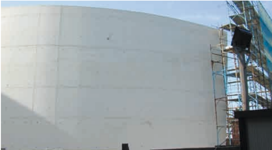
Fig. 16 - Le vele bianche in SCC in fase di esecuzione per la chiesa di S. Pietro Apostolo di Pescara, progettato di Arch. Dal Re ed altri (Roberto Marino, Calcestruzzi Spa).
