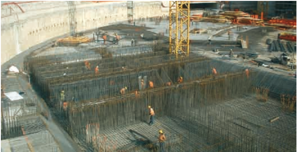
Fig. 14 - Vista di una platea di fondazione fortemente armata (Porta Nuova Garibaldi, Milano - Studio MSC Associati Srl).
