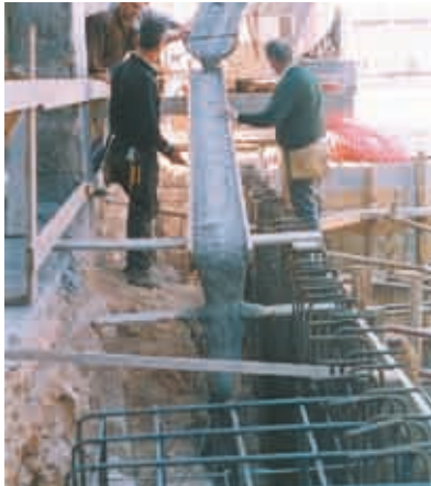
Fig. 11 - Getto di SCC per il consolidamento di fondazioni (Fausto Caciotta, Colabeton).
