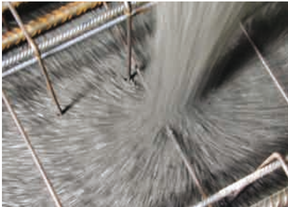
Fig. 1- Getto dell'SCC in movimento (Gabriele Ciatti, Betonval).
