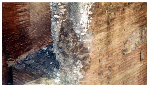
Figura 1. Esempio di calcestruzzo romano gettato tra paramenti in mattoni
