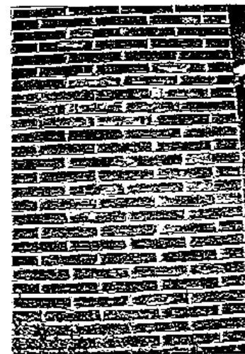
Fig. 5 - Tipica delaminazione di una muratura in mattoni per effetto dei cicli di gelo-disgelo.
