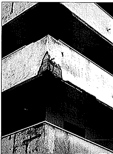
Figura 5 - La corrosione dei ferri di armatura promossa dalla carbonatazione in classe di esposizione XC4
