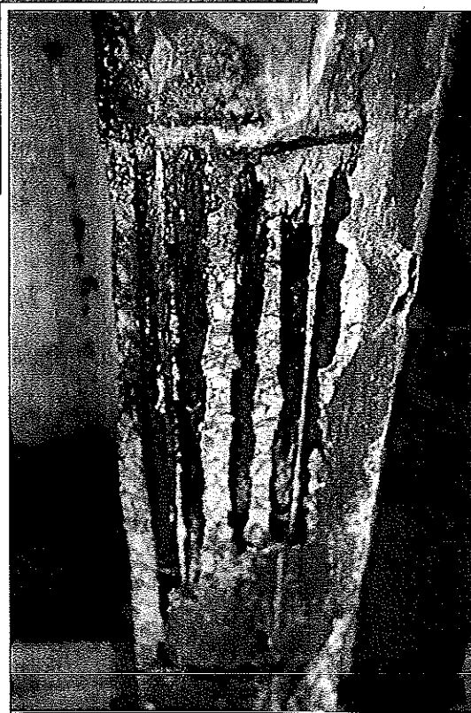
Figura 1 - Un esempio di corrosione dei ferri di armatura in una struttura autostradale esposta a salatura in inverno (classe di esposizione: XF4)
