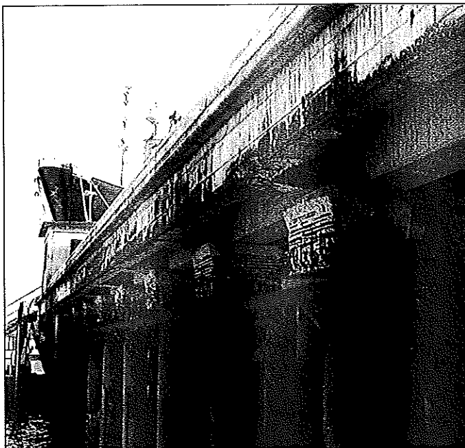
Figura 6 - La corrosione dei ferri di armatura promossa dalla presenza del cloruro in acqua di mare (classe di esposizione: XS3)
