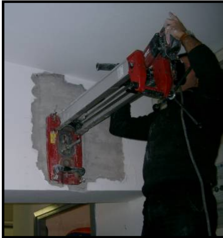
Carotaggio su elementi in c.a.
