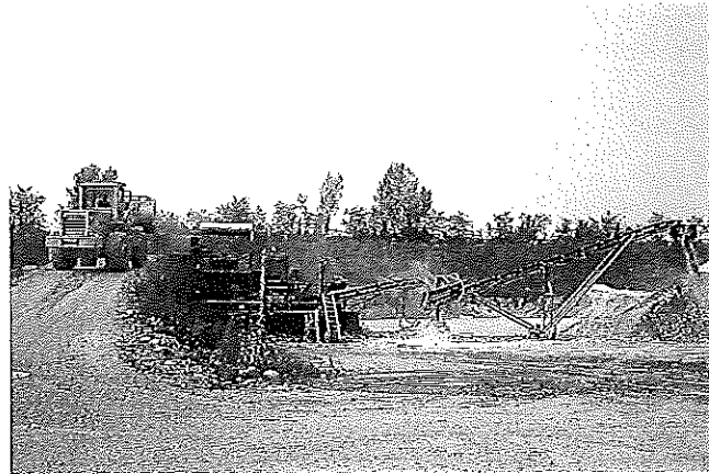
Fig. 3 - Particolare di un impianto di riciclaggio.
