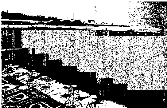
Fig. 20 - Veduta della platea gettata in subacqueo : sullo sfondo lo sbarramento per l'acqua del mare.
